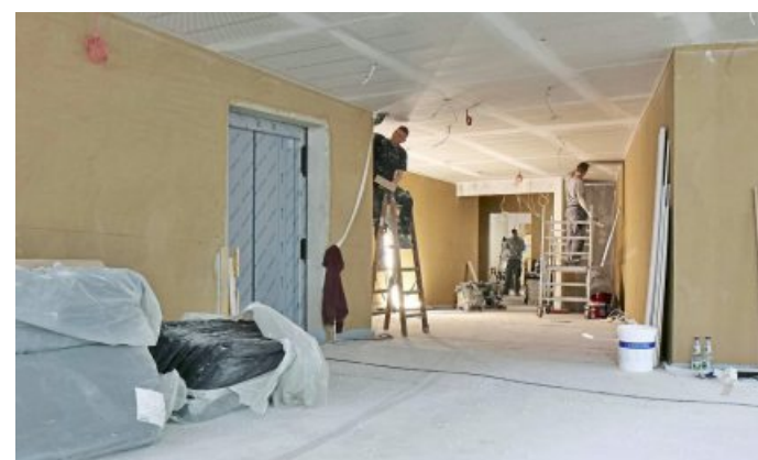
Im Inneren sind die meisten Stromkabel gelegt, die Belüftungsanlage installiert. In der kommenden Woche wird die letzte Estrich-Schicht auf den Boden aufgebracht.
