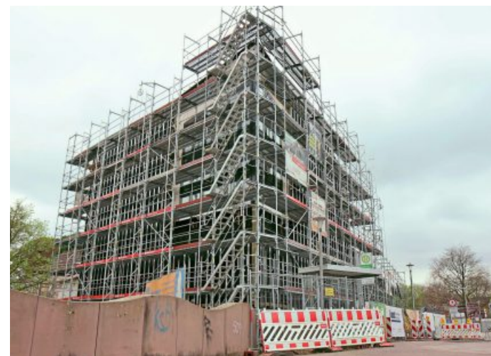
So sieht das neue Sensoria-Gebäude in Holzminden – unweit Weserbrücke und der Landesgrenze zum Kreis Höxter/NRW – zurzeit aus: Es ist eingestüst, die Halterung für die tonnenschweren, charakteristischen Cortenstahl-Kacheln sind montiert.
