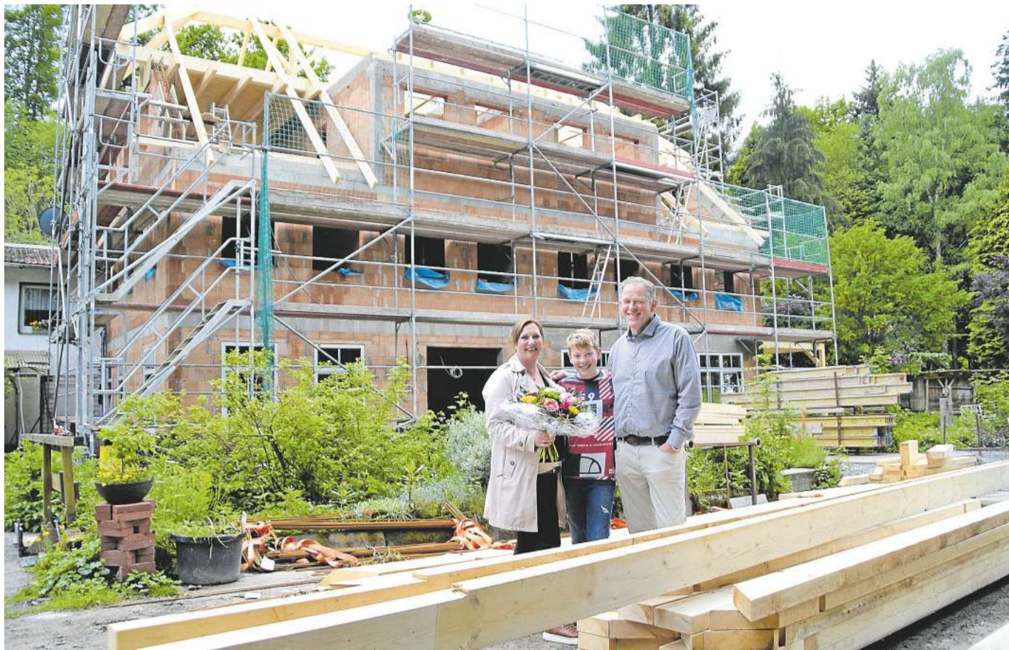
Yvonne, Joe und Udo Timmermann freuen sich darüber, dass die nächste Etappe bei den Bauarbeiten geschafft ist.
